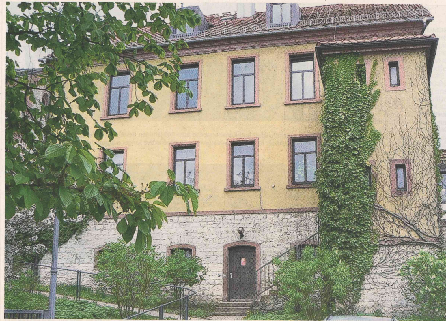
Die Hülle bleibt unverändert: Der Eisinger Bauausschuss schreckt vor Kosten und Problemen einer Außendämmung zurück und macht im Streit um die Sanierung eine Kehrtwende.
